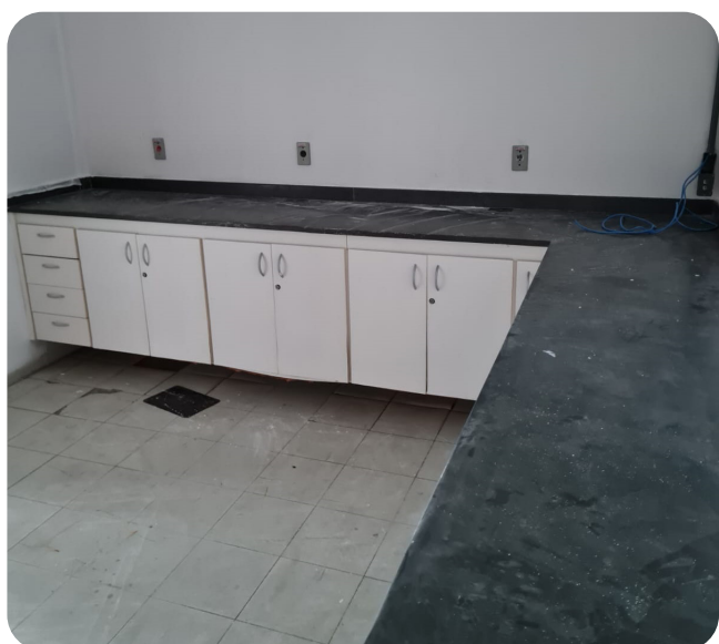
Reforma do Laboratório de Conformidades
