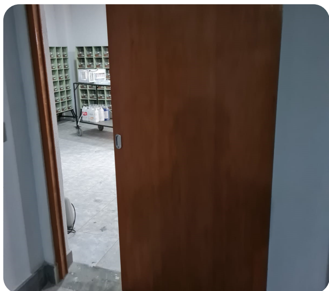
Isolamento da sala de Canto Clássico
